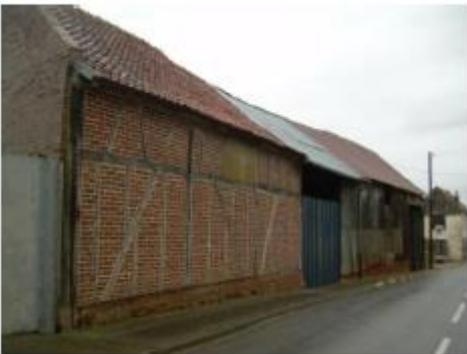
**Appareillage mixte** : Alternance d'assises de craies et de briques qui permet de pallier la faible résistance de la craie et de jouer des couleurs et des formes.
