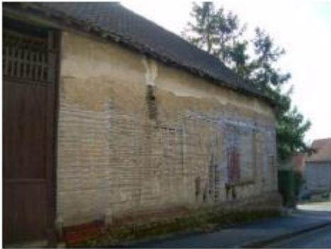
Le torchis est une terre sédimentaire et argileuse qui a longtemps constitué le matériau de construction de base. Le procédé constructif repose sur un système porteur en bois avec un remplissage de torchis.
