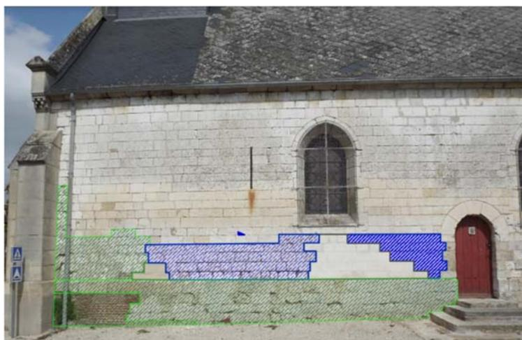
Depuis quelques années, nous constatons une dégradation importante des pierres calcaires du mur de l'église, côté rue d'En Haut.
